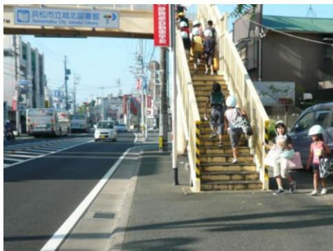
図 7-37 横断歩道橋で急に狭まる歩道
