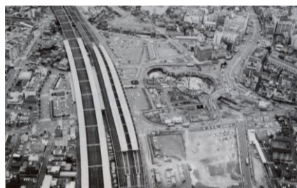
図 2-3 国鉄高架化事業完成の頃
